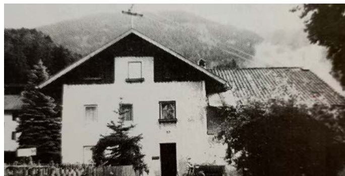
Das alte Mesnerhaus oberhalb des Widums, das 2000 abgerissen wurde
